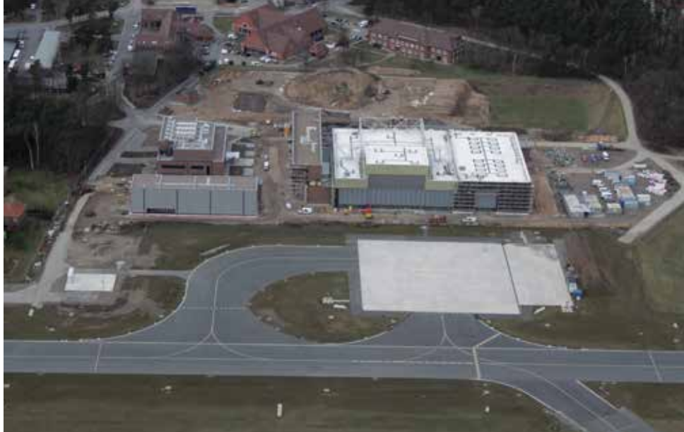
Das neue Internationale Ausbildungszentrum A400M: In die Ausbildungshalle (v. re.) passt eine komplette Maschine. Links daneben die Übungsanlage für den Cargo Hold Trainer - Enhanced, dahinter das Simulatorgebäude.
