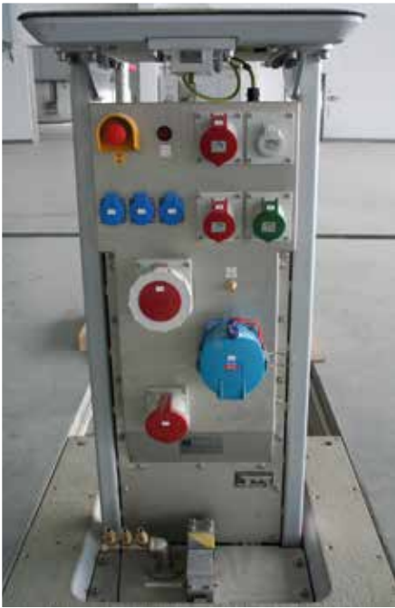
Senkelekranten sind an den Parkpositionen und in den Hallen verbaut. Sie speisen die A400M mit Strom. Per Datenlink verbinden sie die Flugzeuge auch mit dem Netzwerk des Fliegerhorstes.
